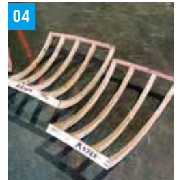
構造物の形状の骨組みを製作
