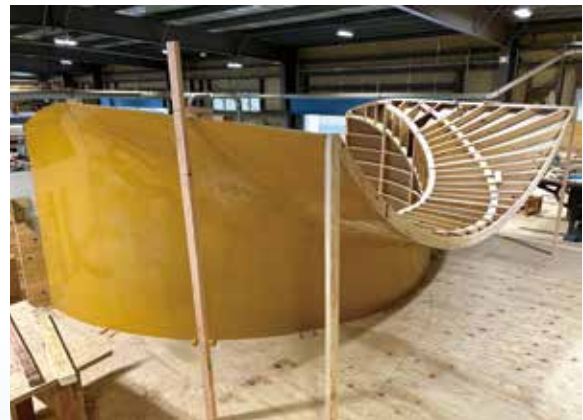
3重アール型枠
