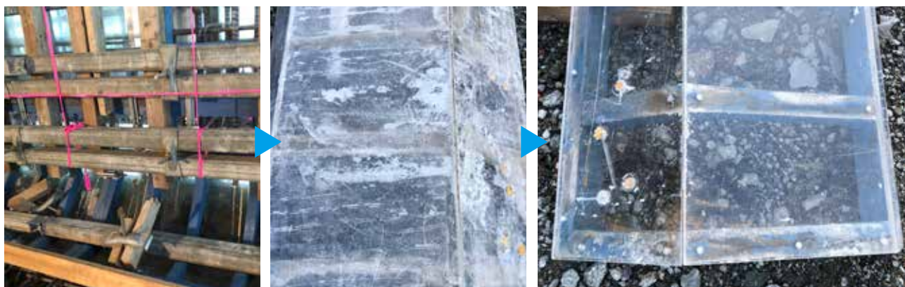
型枠建込の様子
