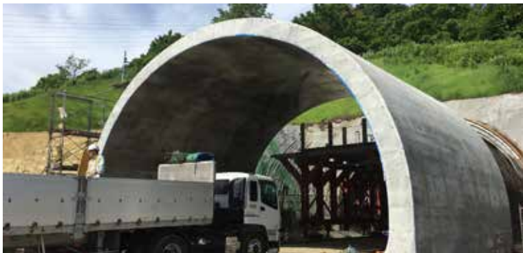
トンネル坑門工躯体
