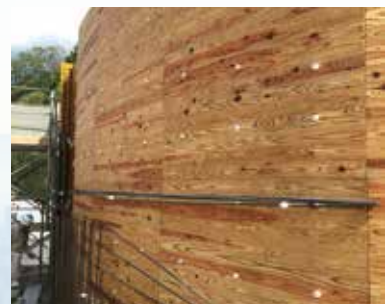
円形杉板本型枠階段
