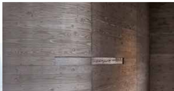
円形杉板本型枠階段
