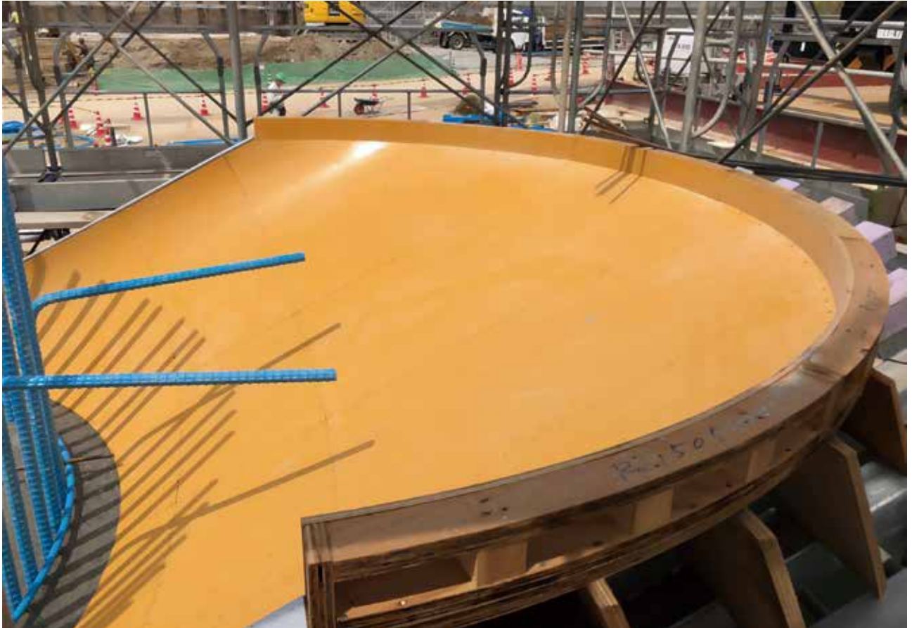
橋脚梁底型枠
