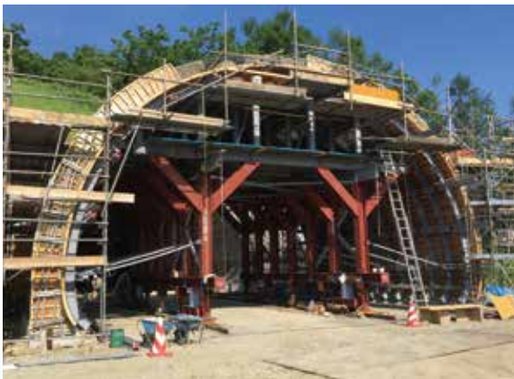
坑門工バラセントル
