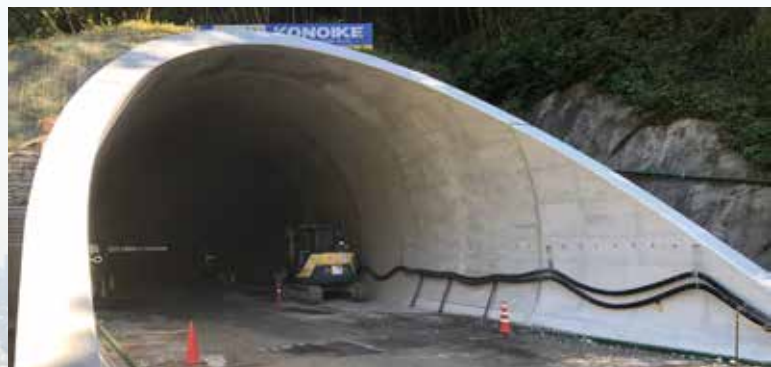
トンネル竹割坑門工躯体
