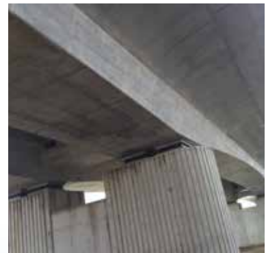
上部工完成躯体
