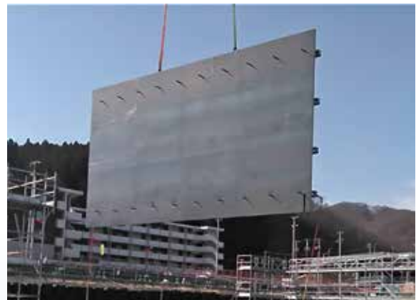
システム型枠吊り込み
