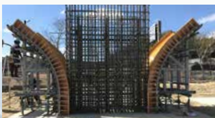
橋脚下部工大組型枠
