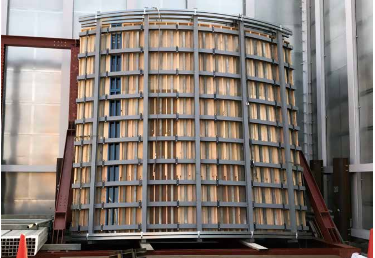
立坑ノーセバ工法
