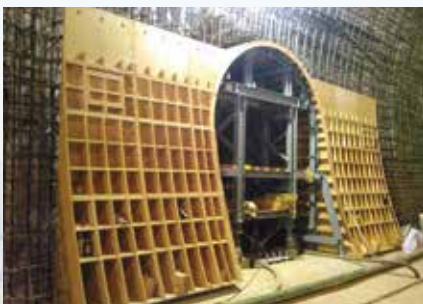
避難工バラセントル
