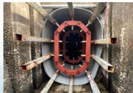
管更生支保工
